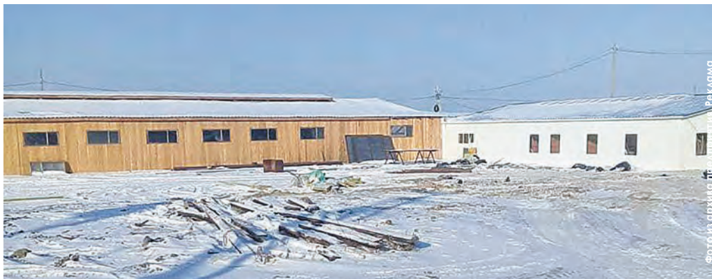
Строится новый коровник с доильным залом с беспривязным содержанием на 300 голов
